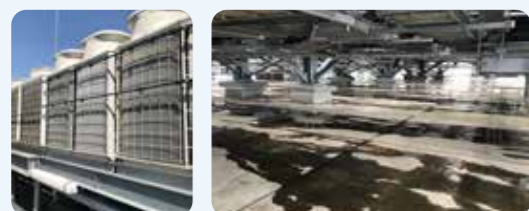
※屋上空調室外機による散布システムを導入
