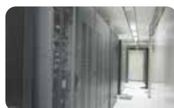
コロケーションルーム
