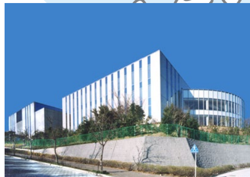
第1データセンター (横浜)
