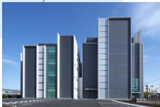
第2データセンター (横浜)
