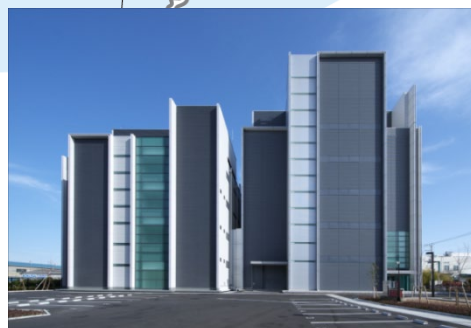
第2データセンター (横浜)
