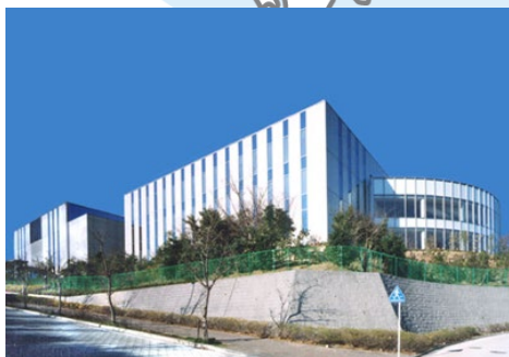
第1データセンター (横浜)
