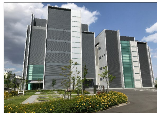
第2データセンター（横浜）
