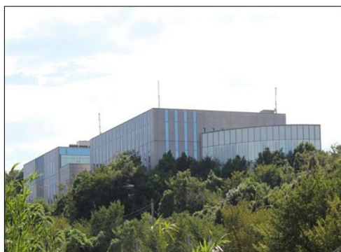
第1データセンター（横浜）
