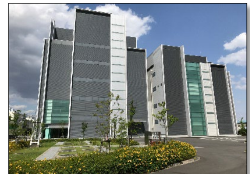
第2データセンター
