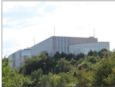
第1データセンター
