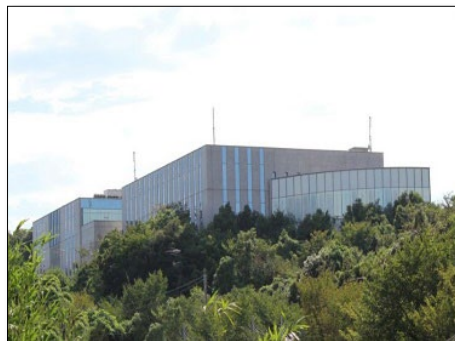
第1データセンター
