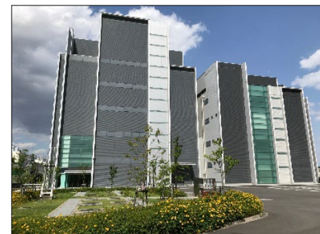
第2データセンター
