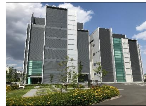
第2データセンター
