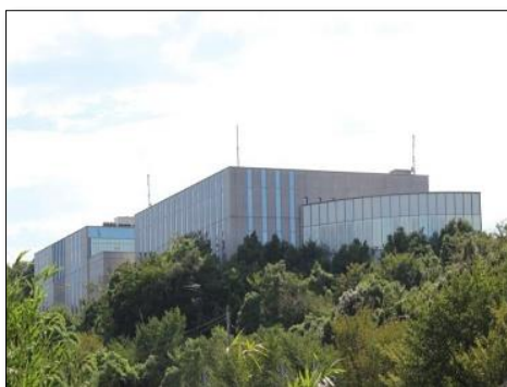
第1データセンター
