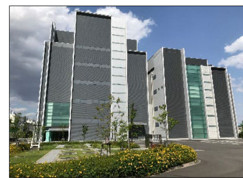
第2データセンター
