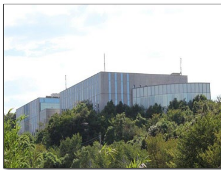
第1データセンター
