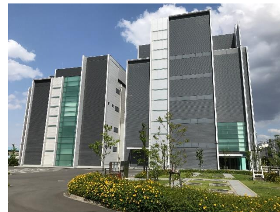
第2データセンター
