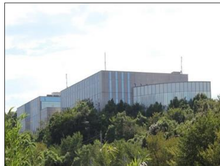
第1データセンター
