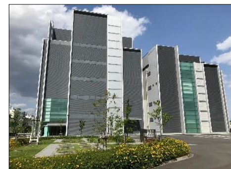
第2データセンター
