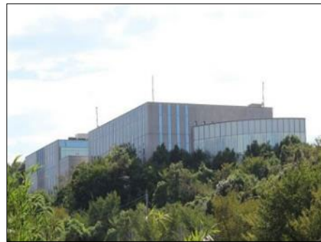
第1データセンター
