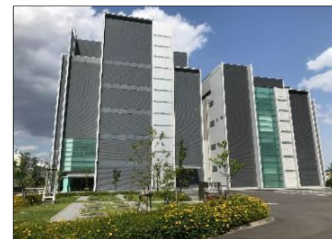
第2データセンター
