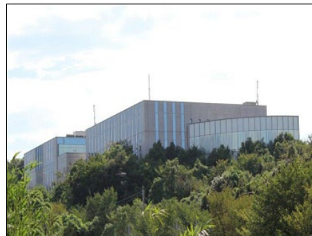
第1データセンター
