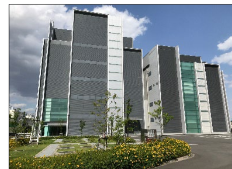
第2データセンター
