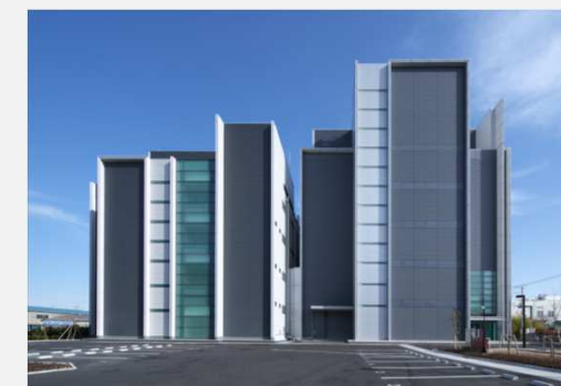
第2データセンター(横浜)
