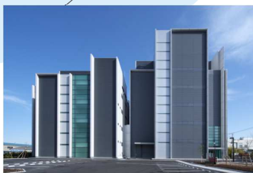
第2データセンター (横浜)
