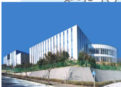
第1データセンター (横浜)
