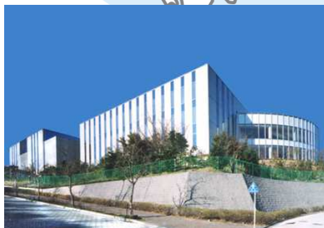
第1データセンター (横浜)
