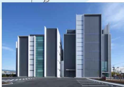
第2データセンター (横浜)
