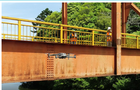
アイネット、ドローンアカデミー、君津市は、橋梁などのインフラをドローンを使って点検する実証実験を進めている。
