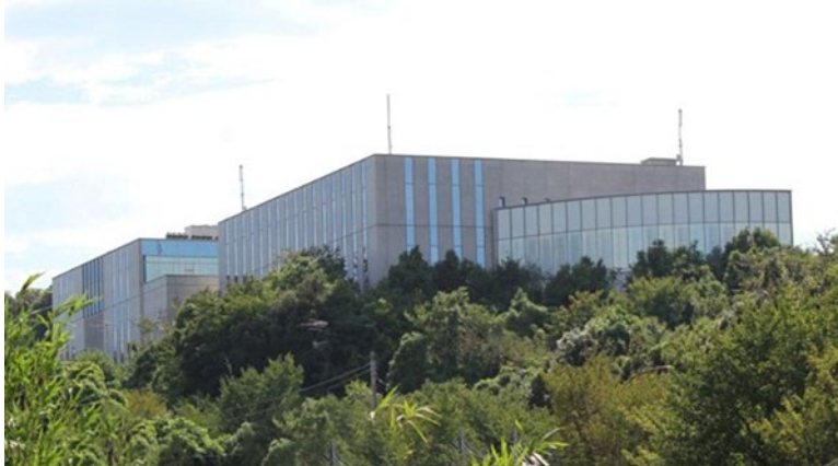
アイネット第1データセンター
