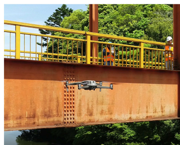
ドローンによる橋梁点検
